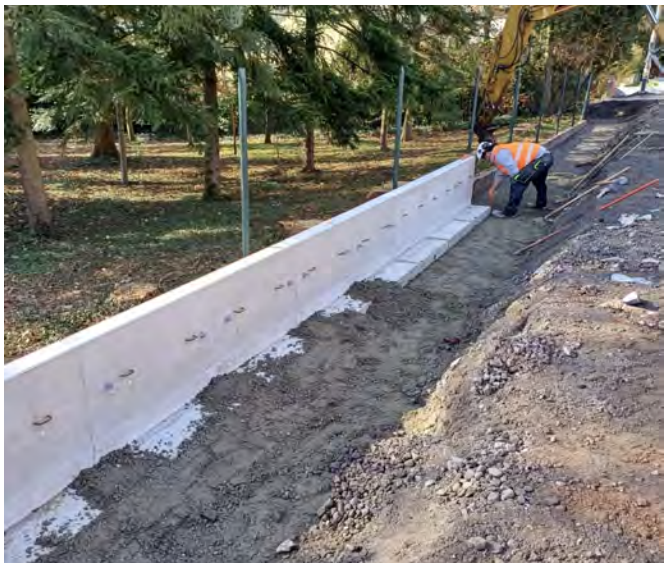
Mise en œuvre des murs en L
