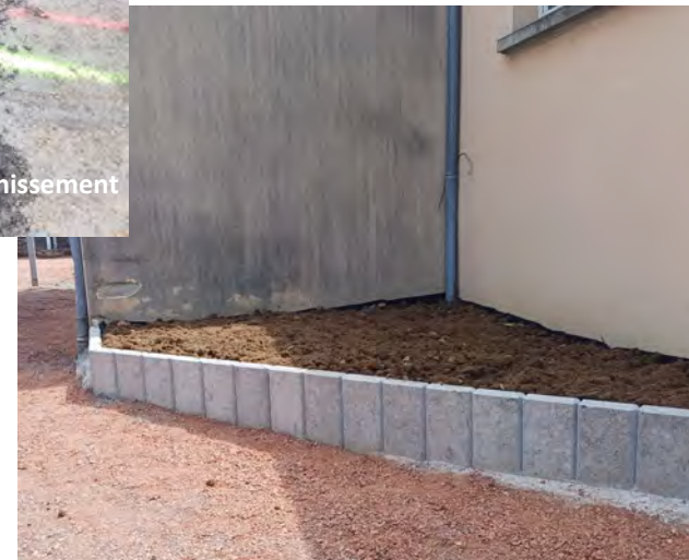
Pose de palissade
