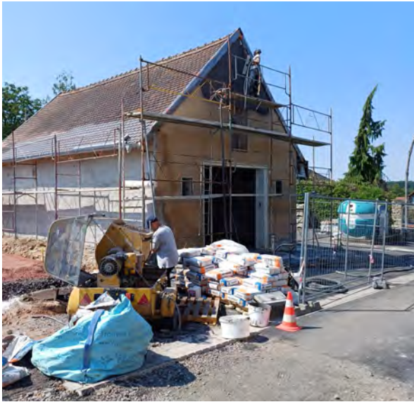
Restauration de l'ancien local des pompiers (Spritzehaus)
