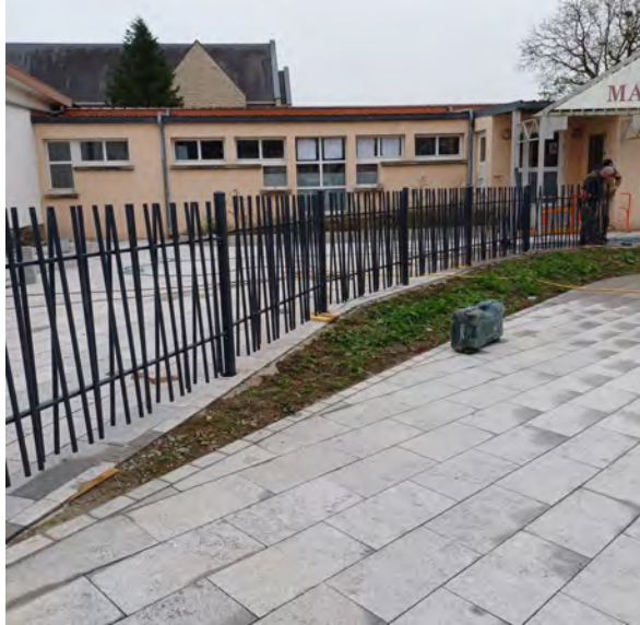
La nouvelle clôture de l'école maternelle est du meilleur effet
