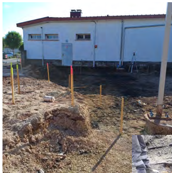
Terrassement à côté de l'école
