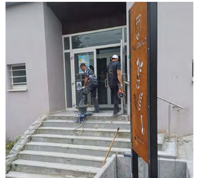
Rénovation de l'entrée principale de la salle (escalier, garde-corps, totem)
