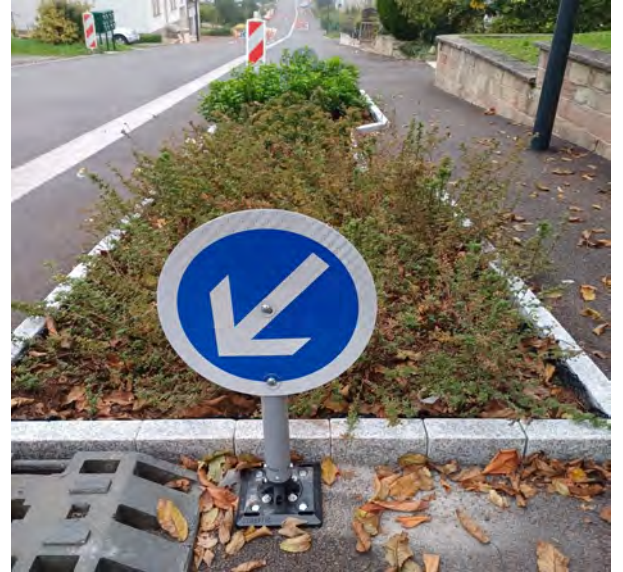
Les panneaux de signalisation sont en bonne place
