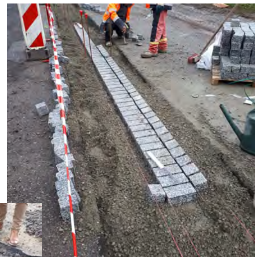
Réalisation du caniveau en pavés granit
