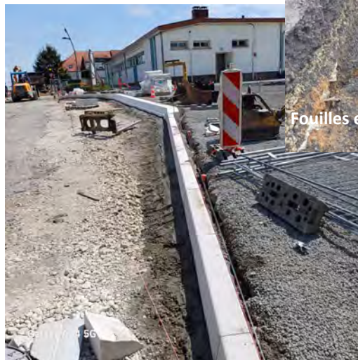
Pose de bordures pour l'arrêt de bus
