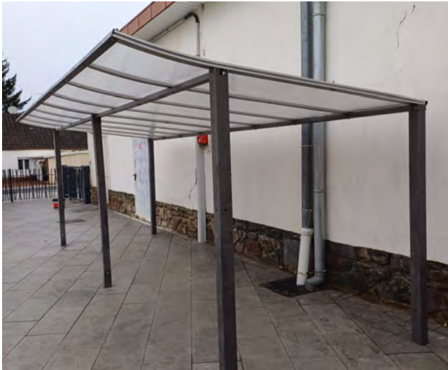
L'abri-vélos est en place
