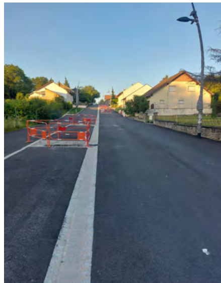
Mise en œuvre des enrobés sur la chaussée et les stationnements
